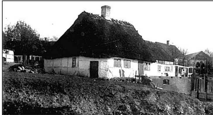
Den gamle bygning der nu er delvis nedbrudt. Bagerst til venstre ses Søholmvej 14 og bagerst til højre ses Søholmvej 12, Søholmvej 8A og laden til Søholmvej 8.
