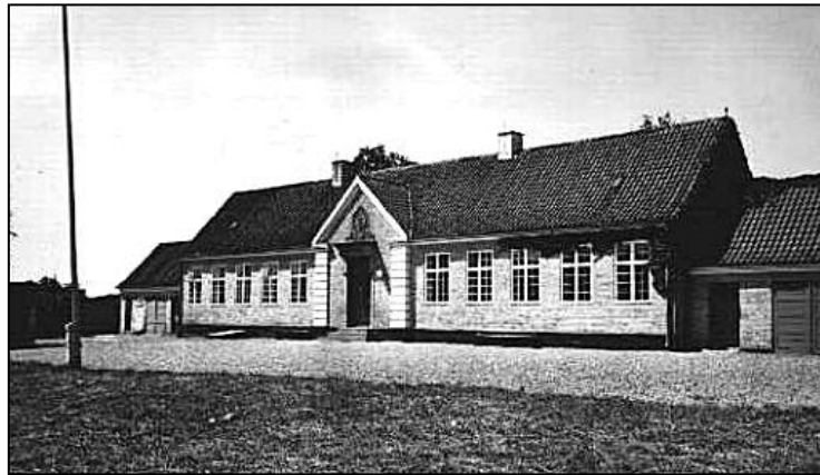
Foto af den nyopførte skole.
